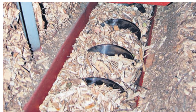
Eine «Schnecke» (unten) transportiert Schnitzel (möglich sind auch Holzabfälle) in den Brenner mit Filter (oben); in einem späteren Schritt kann die Anlage um einen doppelt so grossen Brenner erweitert werden. Der Speicher ist ein 100 000-Liter-Tank (rechts). Die Abwärme im Heizungsraum wird durch das Rohr (rechts, oben) in die Einstellhalle geblasen.
